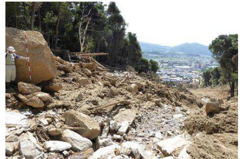
写真 3 八木 3 丁目県営緑丘住宅付近
