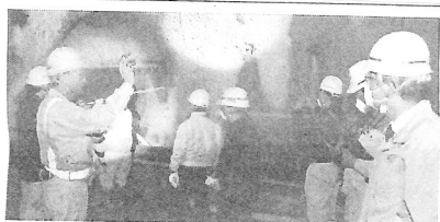
既設トンネルとの接続部
