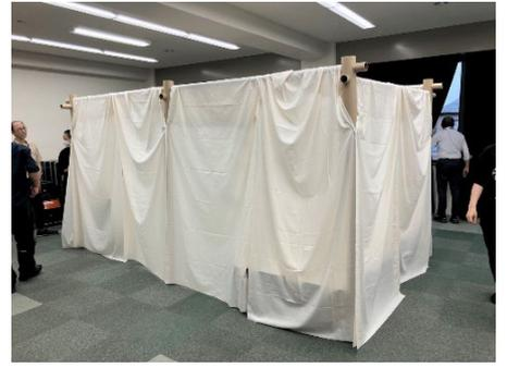
PPS 紙管間仕切りの作成実習（2m×4m）（柱、梁を組立て、布で覆い完成）の様子
