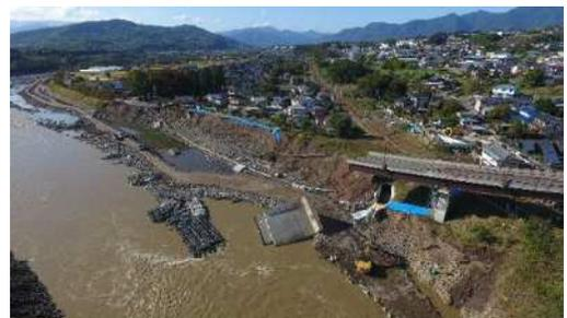
写真-2 洪水の氾濫による堤内地の橋梁の流失<sup>8)</sup>
