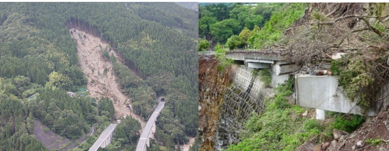
斜面崩壊と道路橋落橋：豪雨
